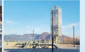
고령합천 LNG 가스배관
