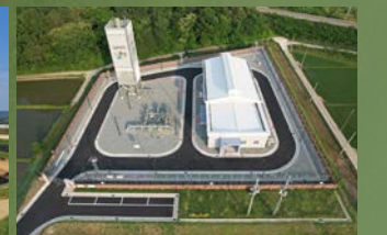
장흥보성 LNG 가스배관
